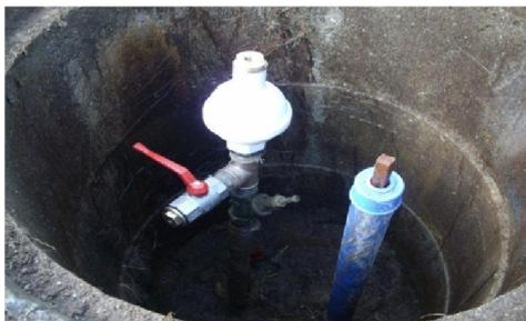
Den **Entlüftungsventilen** wurde in der Vergangenheit zu wenig Aufmerksamkeit geschenkt. Teilweise waren die Standorte nicht mehr bekannt oder auch der Deckel mit Gras überwachsen. Zwei der insgesamt vier Entlüftungsventile hatten sich zu unterirdischen Springbrunnen entwickelt. Die defekten Ventile wurden ausgetauscht.
