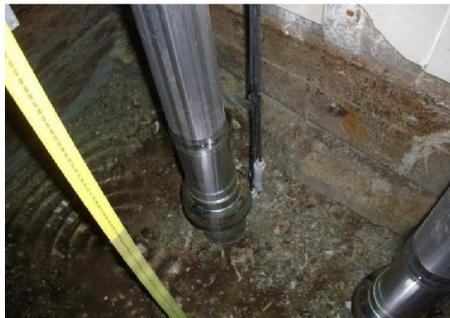
In der Quellstube Tiefstein war ein **Rückschlagventil vom Ansaugstutzen undicht**. Während der Stillstandzeiten der Pumpen, floss Wasser unbemerkt in den Quellbereich zurück. Durch diesen Fehler verloren wir rund 500 Liter pro Stunde.
