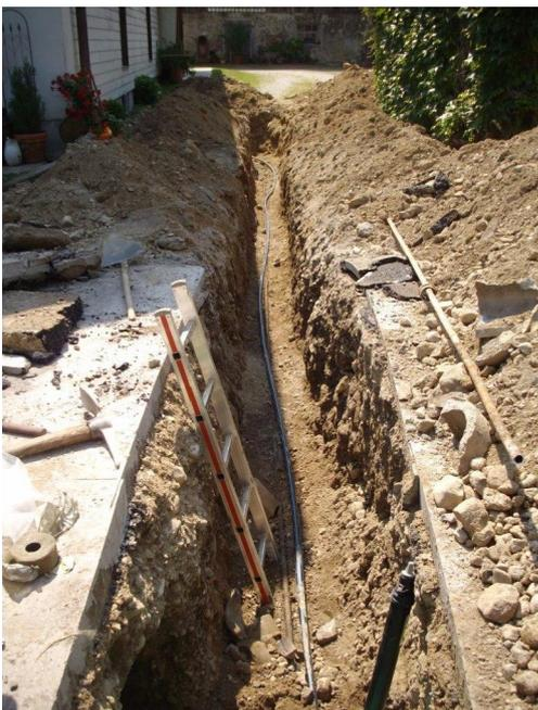
Hausanschlüsse wurden früher durchwegs mit Eisenleitungen errichtet. Diese sind in die Jahre gekommen und waren teilweise durchgerostet. In der Vergangenheit, wurden solche Leitungen nur repariert oder die durchgerosteten Abschnitte ersetzt.
