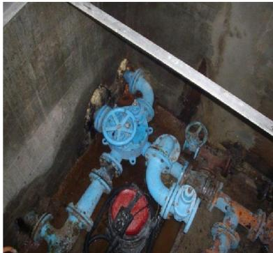
Die **Schieberkammer** beim Hochbehälter war in die Jahre gekommen und einige Verbindungen waren nicht mehr dicht. Da ohnehin der Einbau neuer Abgangszähler geplant war, wurde eine Generalsanierung durchgeführt.
