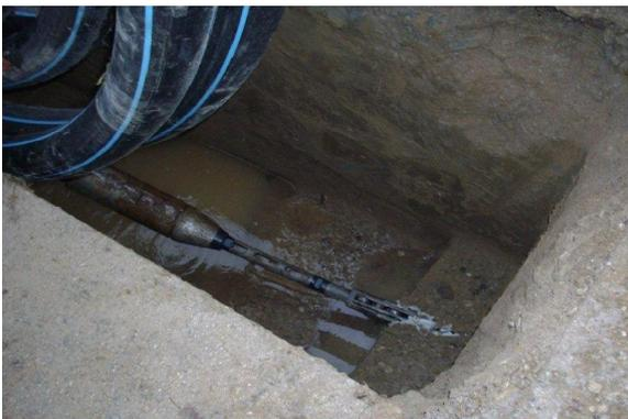
Problematisch waren Faserzementrohre in jenen Gebieten, wo es in den letzten Jahren Erdbewegungen gab. Speziell bei Straßenabschnitten, wo für Kanal, Erdwärme, Gas etc. gegraben wurde und anschließend das Erdreich wieder verdichtet (gerüttelt) wurde. Bei schwierigen Straßenabschnitten wie der Landesstraße und wichtigen Straßen im Ort, wurde mit einem Berstlining-Verfahren eine neue Kunststoffleitung grabungslos in die
